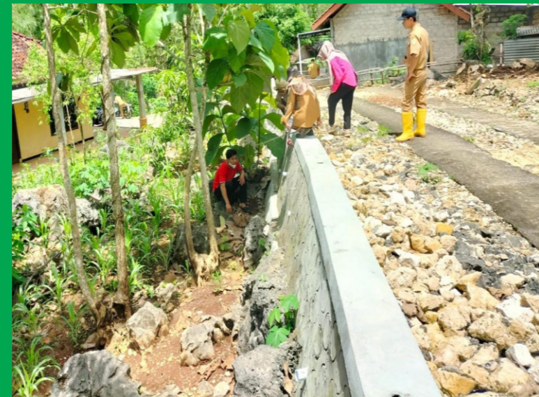
Talud jalan Padukuhan Siyono B
